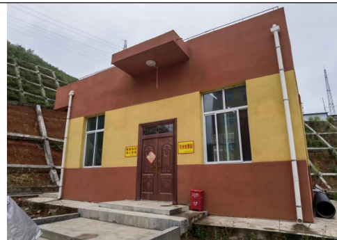
生活污水处理站
