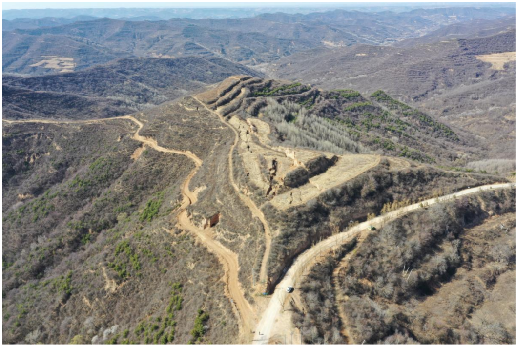
丈招路西侧耕地裂缝、塌陷现状
