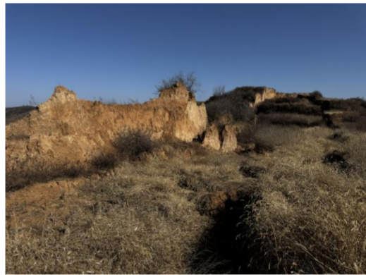
丈招路西侧耕地裂缝、塌陷现状
