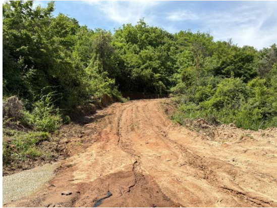
B45 场地临时施工便道现状
