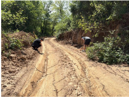
CP1 场地临时施工便道现状
