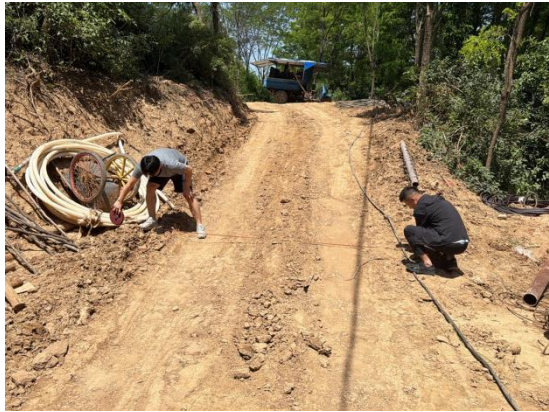
G15 场地临时施工便道现状
