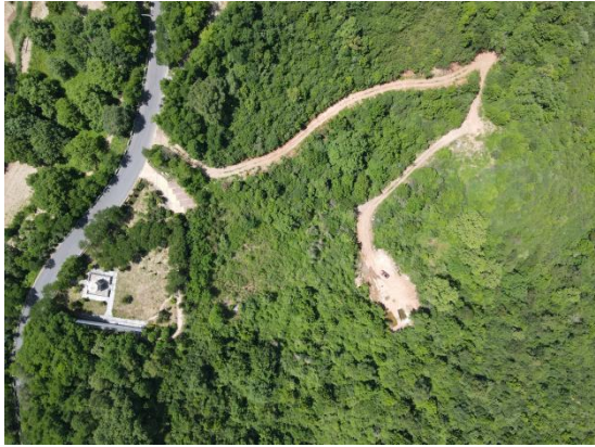
B45 地面抽排钻孔场地现状
