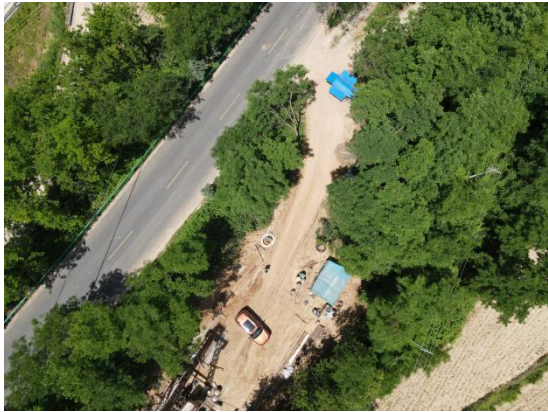
G15 地面抽排钻孔场地现状
