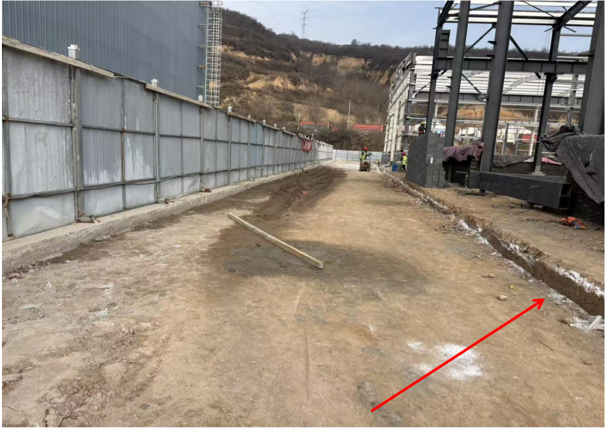
实施排水沟工程
