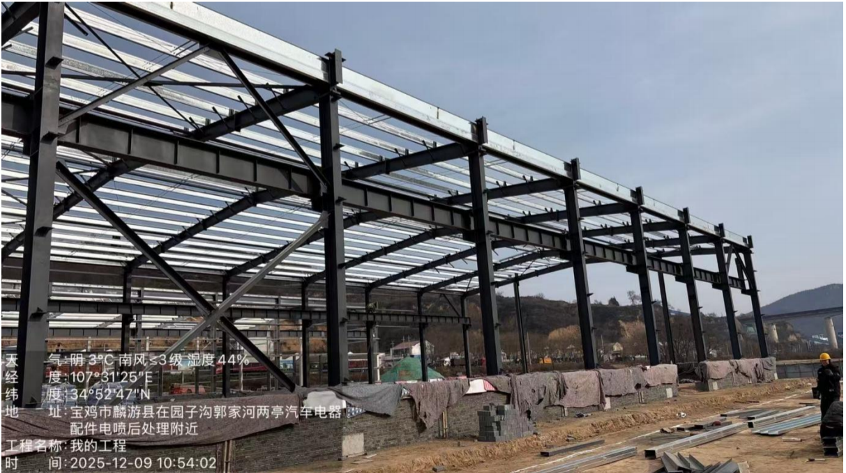
厂房主体构筑物现状
