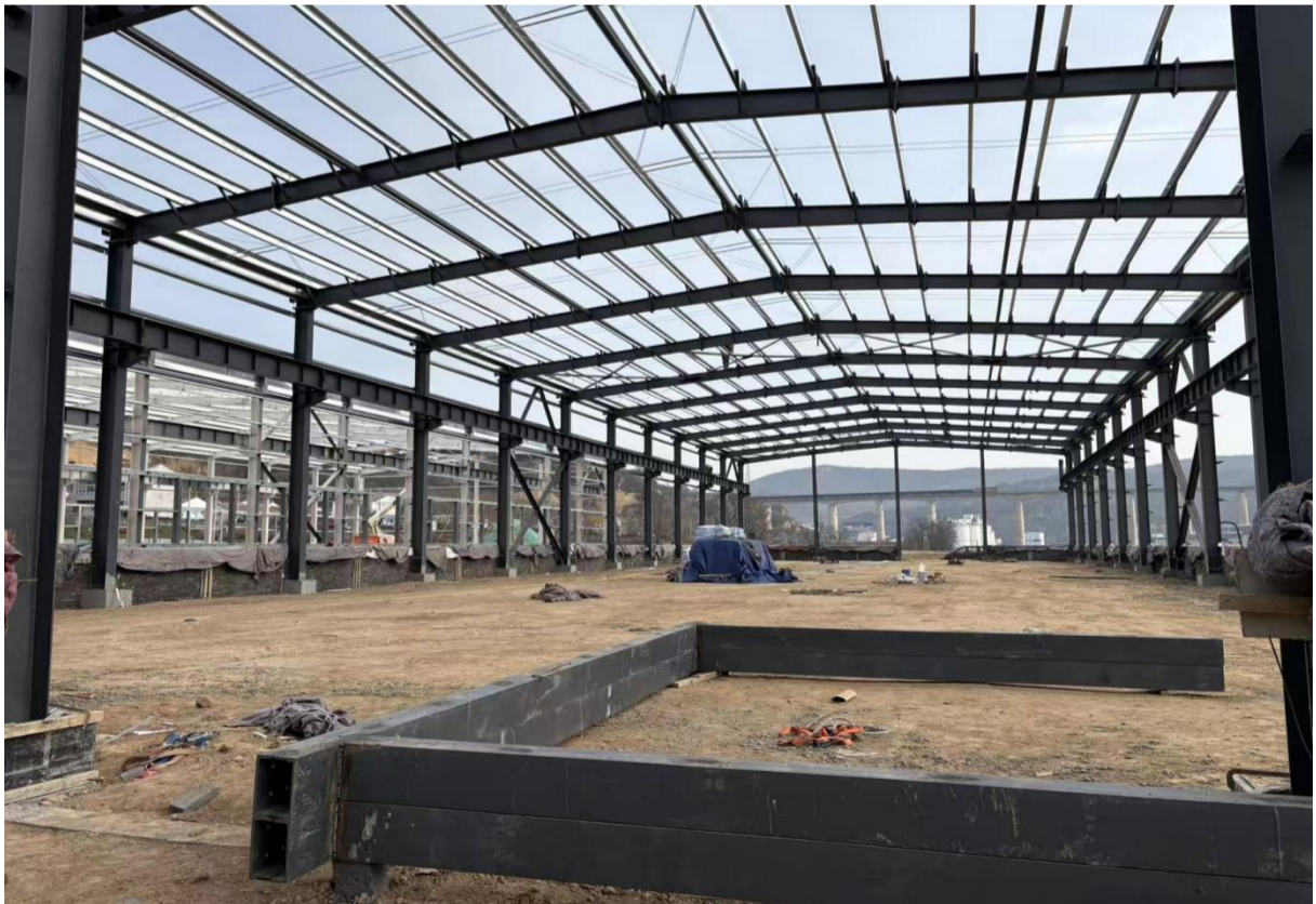
厂房内工程现状
