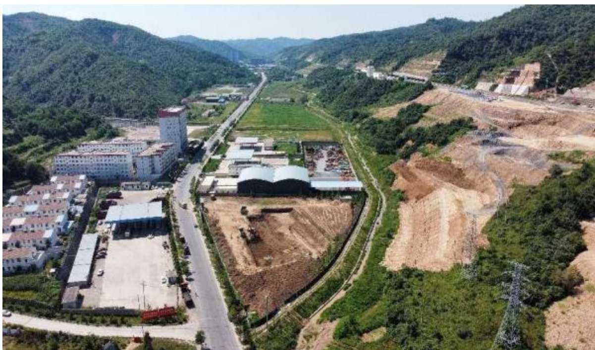
项目地现场踏勘照片
