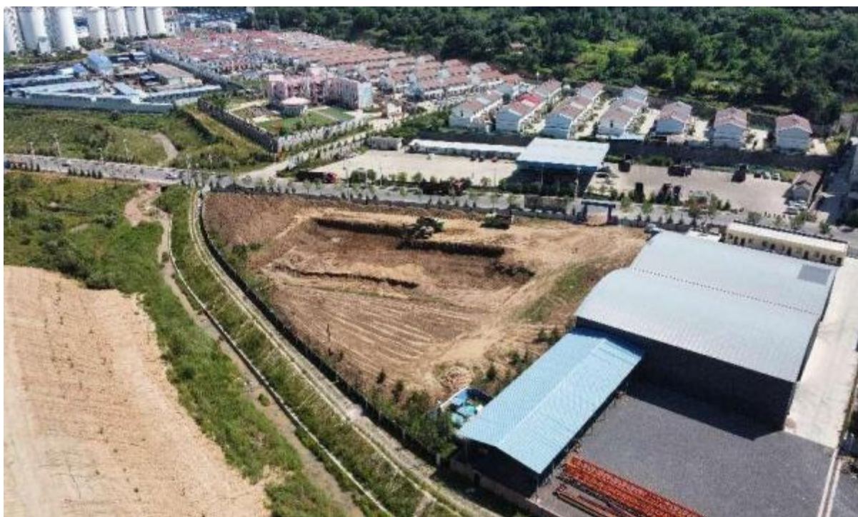
项目区航拍图
