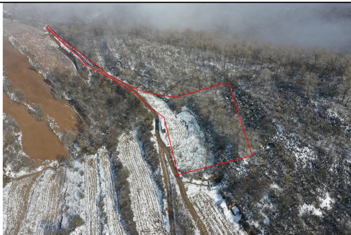
图1 项目区总体航拍图（2024年11月）
