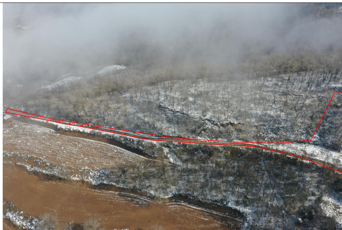
图2 项目区施工道路（2024年11月）
