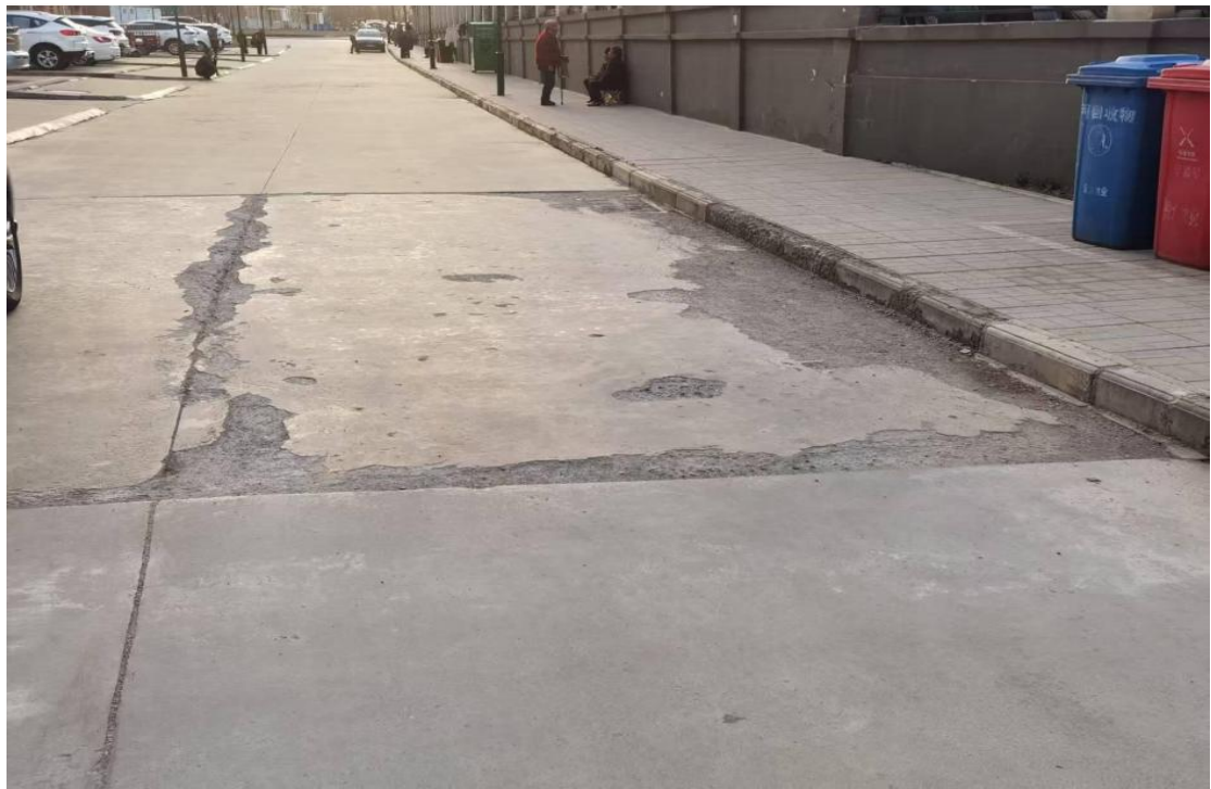
项目区道路现状照片（2026.03）
