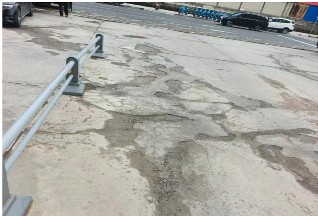
项目区道路现状照片（2026.03）
