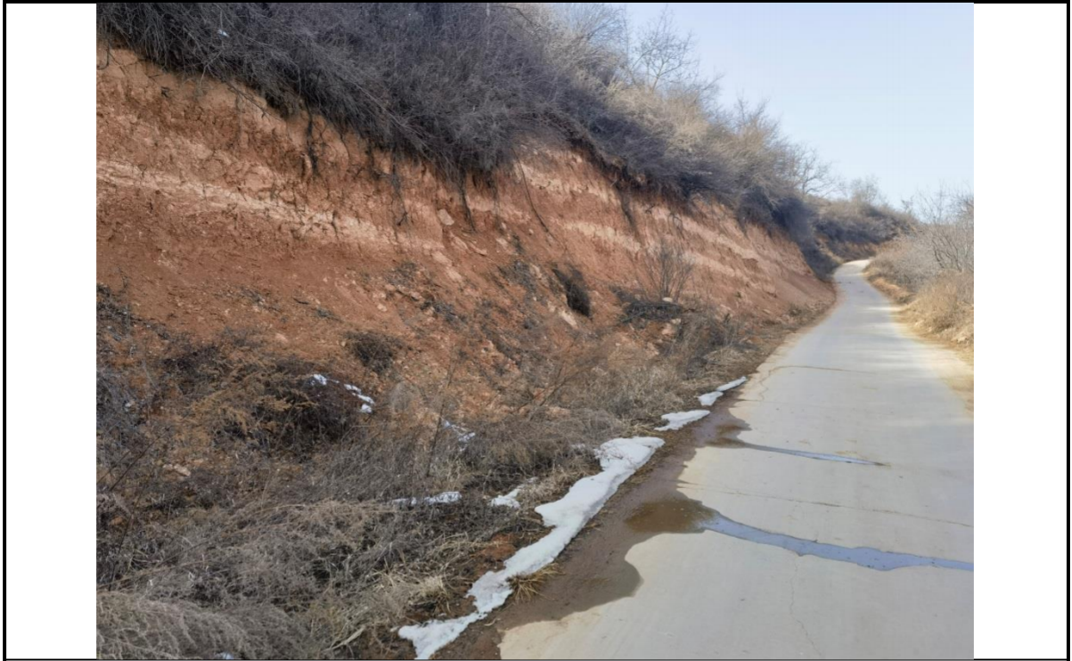
规划挡墙段现状 1（拍摄时间：2026.1）
