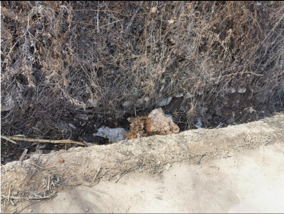
规划排水渠现状 2（拍摄时间：2026.1）
