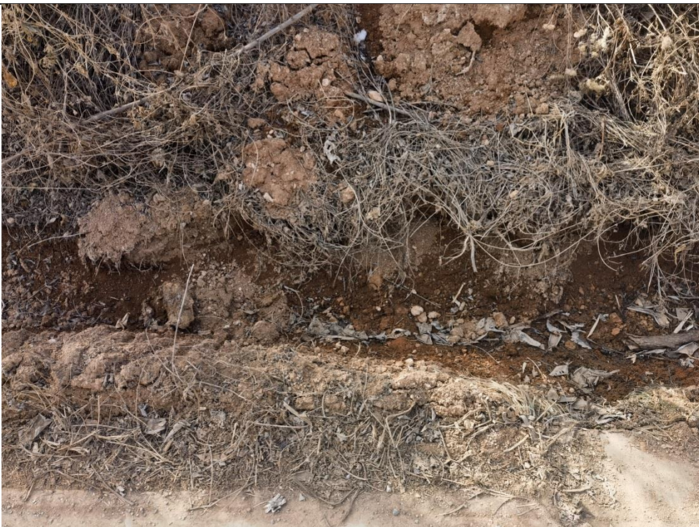
规划排水渠现状 1（拍摄时间：2026.1）
