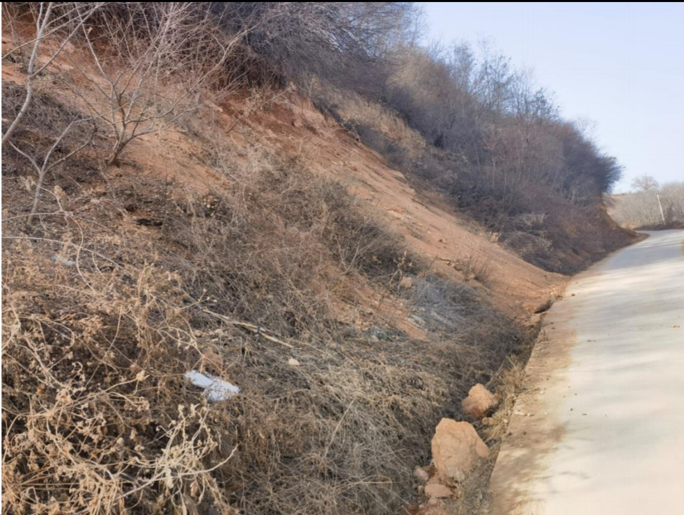
规划挡墙段现状 3（拍摄时间：2026.1）
