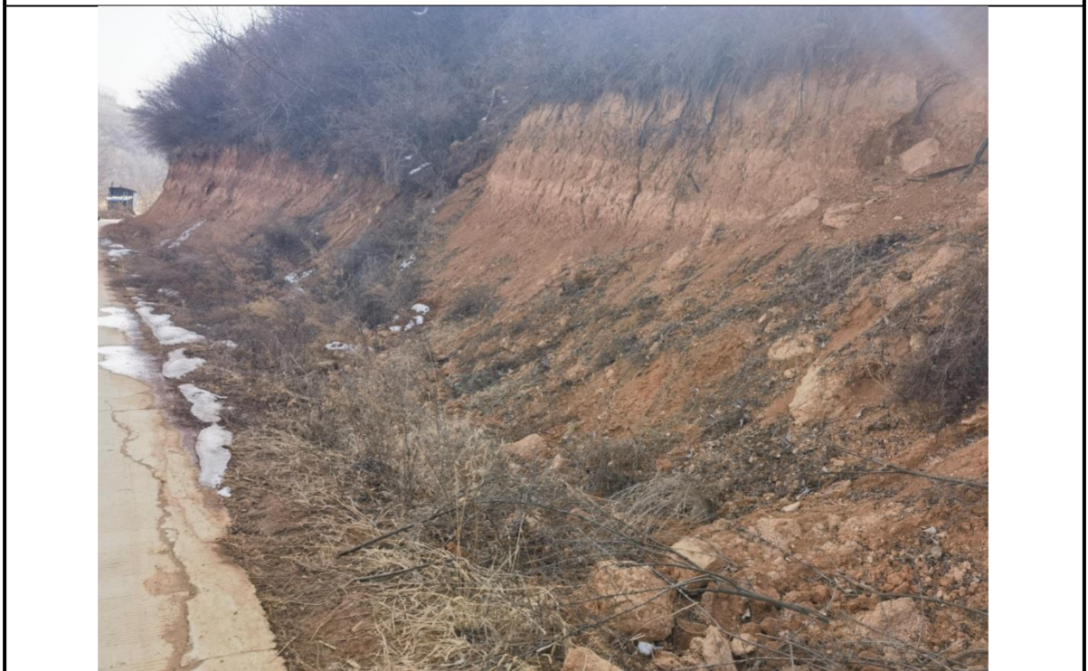
规划挡墙段现状 2（拍摄时间：2026.1）
