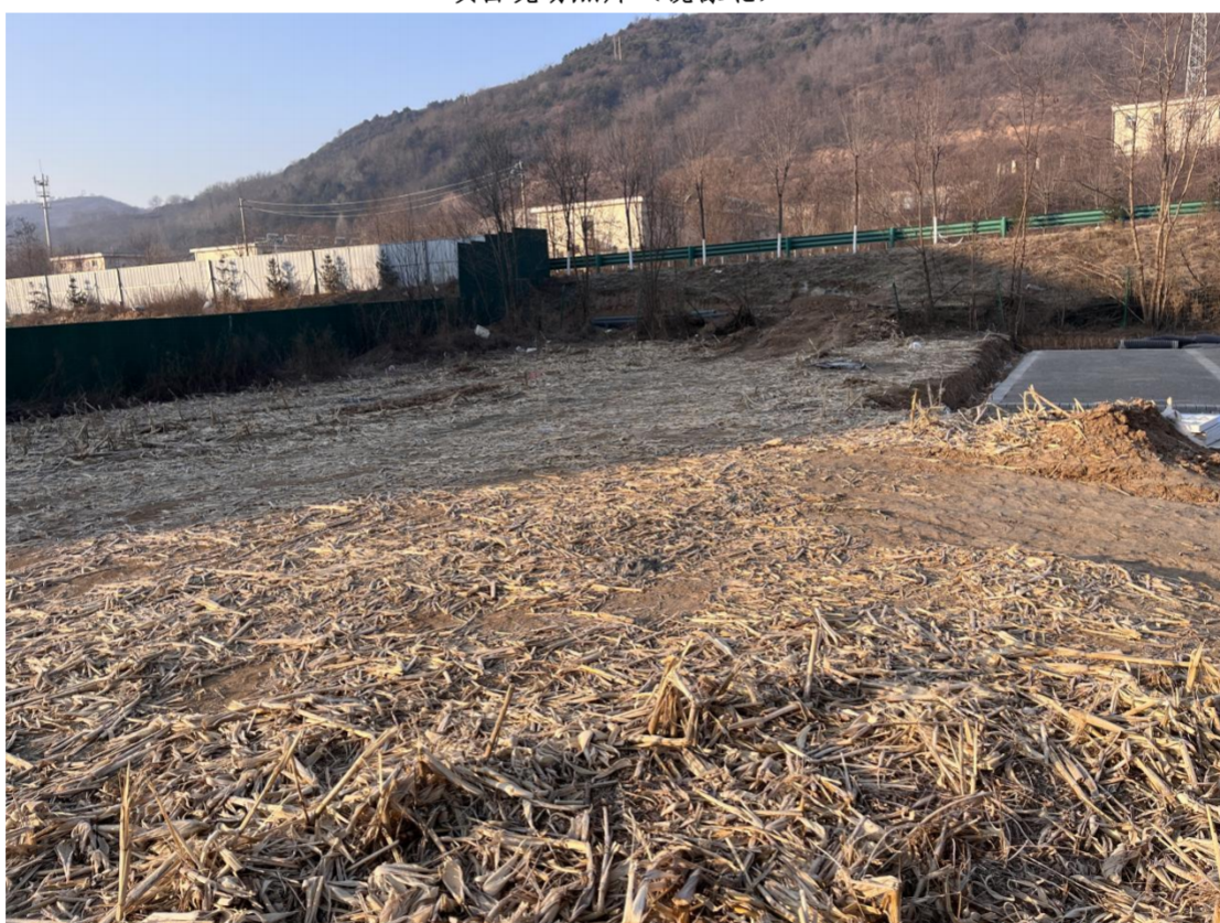
项目现场照片（镜像西南）
