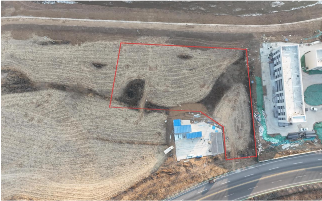
项目区俯拍 1（红线区域为项目建设用地）
