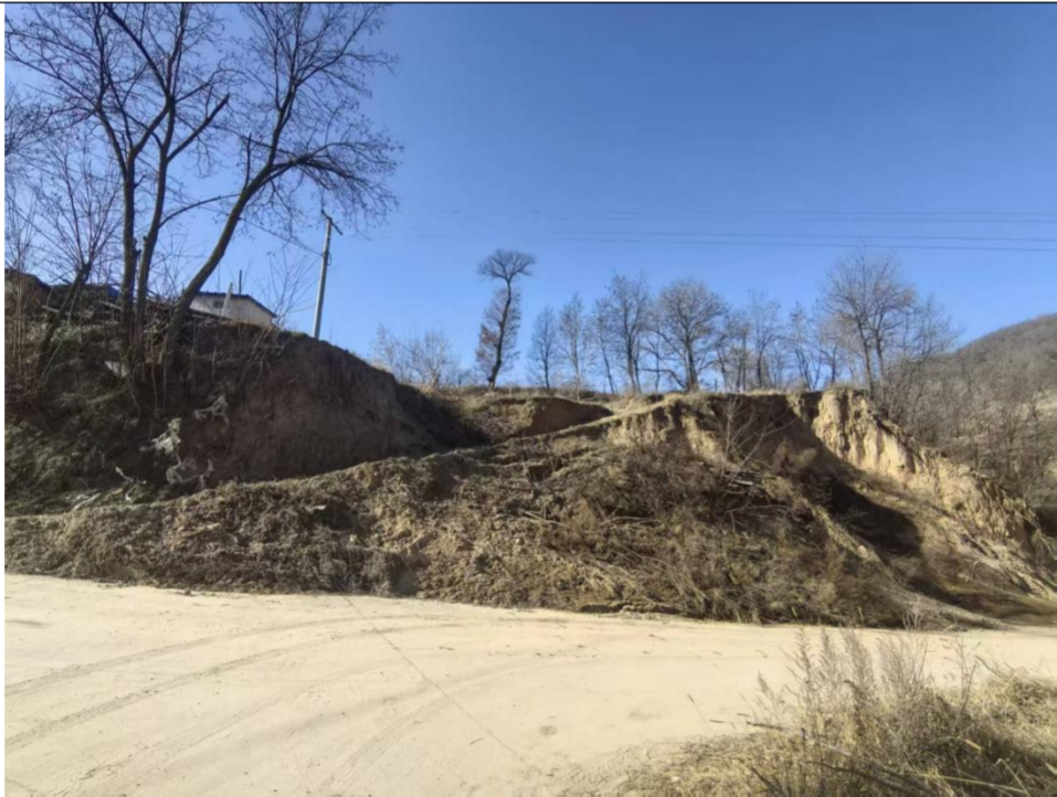
挡墙建设前现状 2 (拍摄时间: 2025.12.12)
