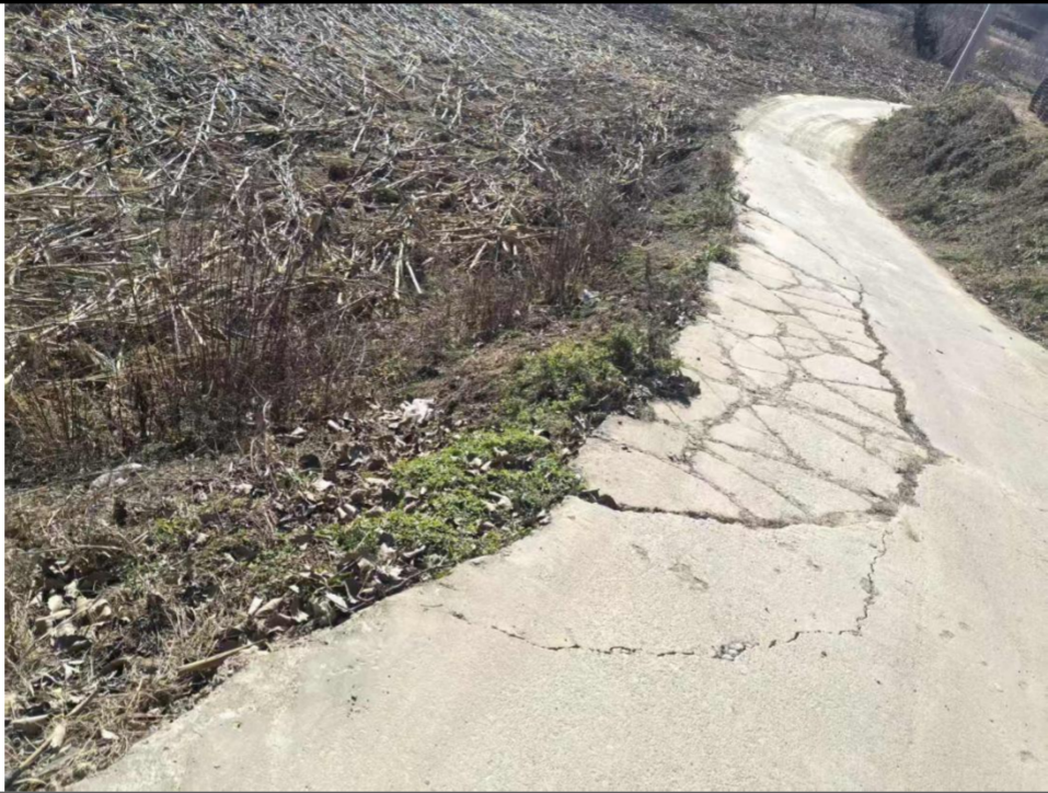
待修复路面 3+挡墙建设前现状 1 (拍摄时间: 2025.12.12)
