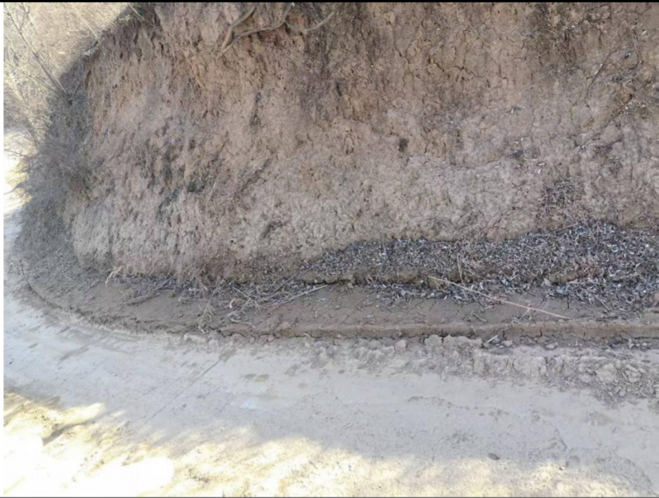
排水渠建设前现状（拍摄时间：2025.12.12）
