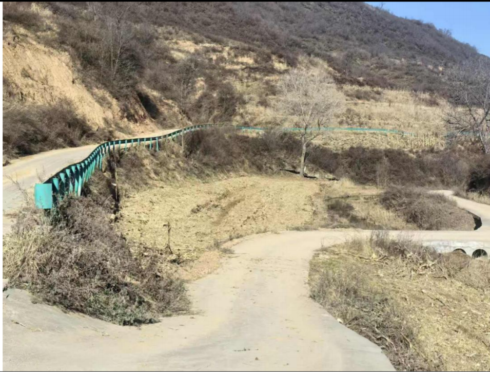
挡墙建设前现状 3 (拍摄时间: 2025.12.12)
