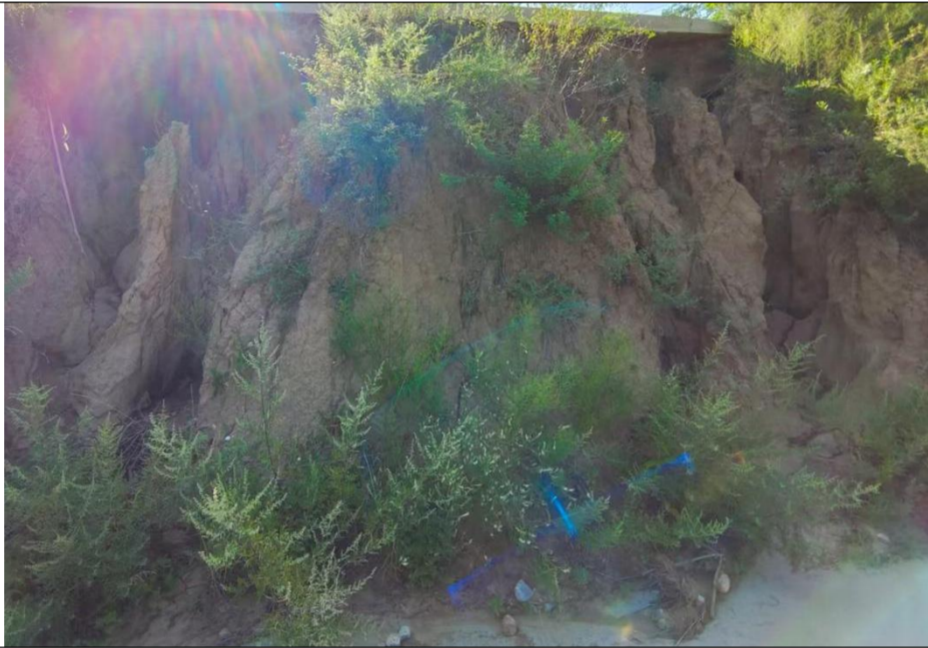
挡墙建设前现状 6（拍摄时间：2025.9.8）
