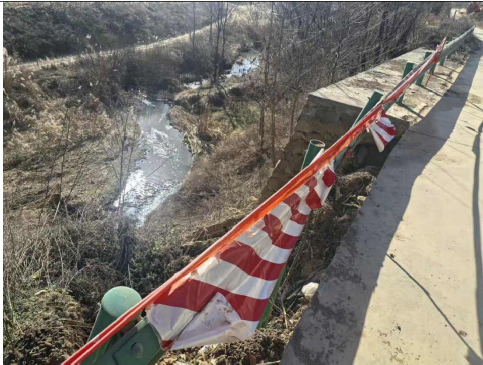
挡墙建设前现状 4 (拍摄时间: 2025.12.12)
