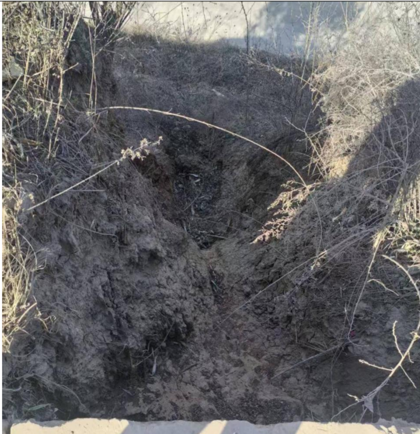
圆管涵建设前现状 (拍摄时间: 2025.12.12)
