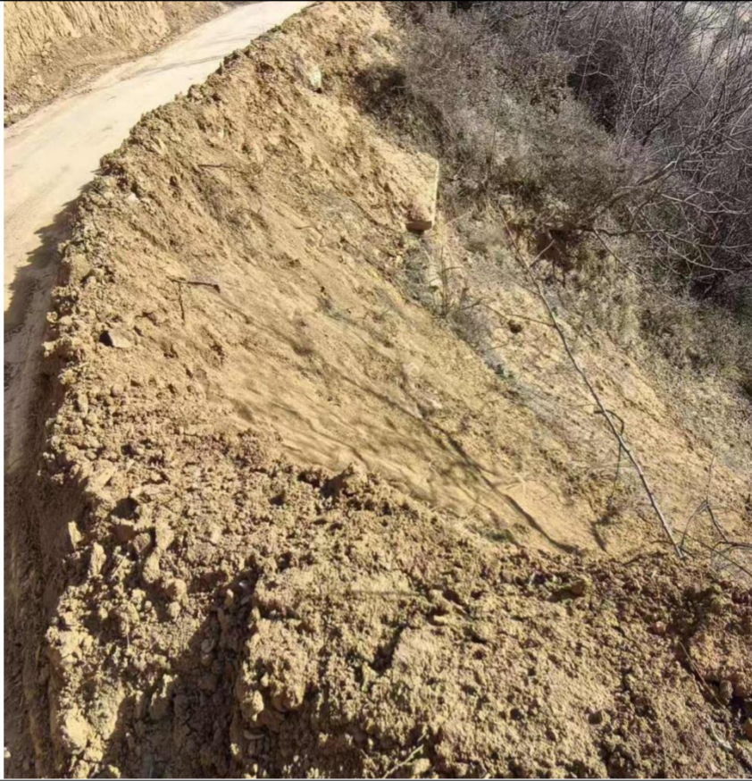
挡墙建设前现状 5 (拍摄时间: 2025.12.12)
